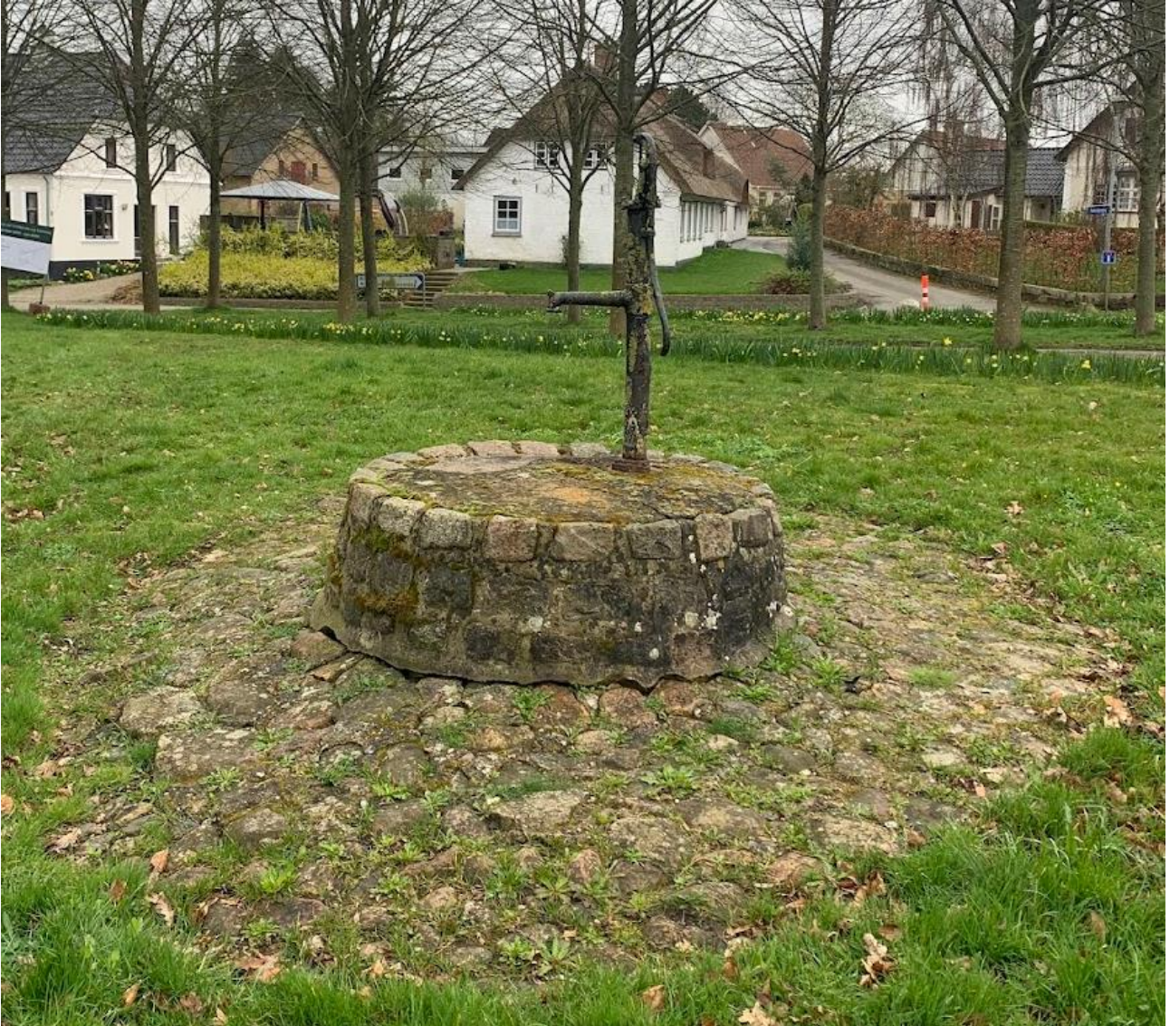
Denne konstruktion trænger til afrensning og vedligeholdelse.
